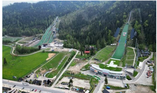
Smučarski skakalni center Zakopane
