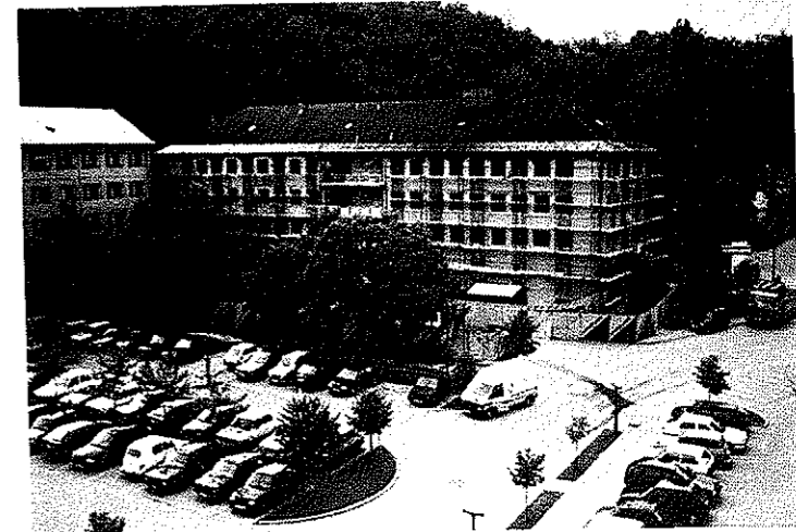
Pionirjev samski dom dobiva z rekonstrukcijo novo podobo in nove stanovalce. V zgornjih etažah je z 28. julijem nastanjen Pionirjev projektivni biro, prva etaža pa bo konec meseca na voljo zunanjim odjemalcem za potrebe poslovnih prostorov. Zanimivost rekonstrukcije, je bila v izsekavanju odprtih in fasadi, s katerimi je objekt dobil lepši in sodobnejši zunanji izgled.
