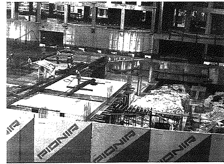
S tem posnetkom vidimo sistem fazne gradnje parkirne hiše, ki se z gradnjo približuje k B objektu.
