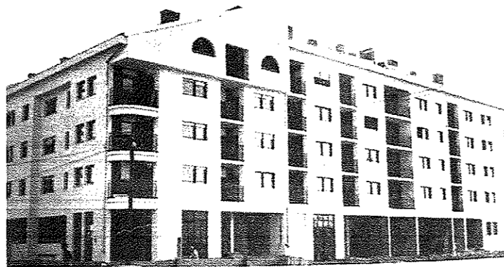
Poslovno stanovanjski blok KA 2 STENJEVAC. V objektu je 48 stanovanj, ki naj bi bila vseljiva v letošnjem decembru.
