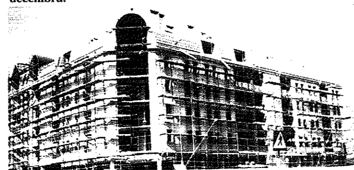
Poslovno stanovanjski blok KD-3 Malešnica v izgradnji. V objektu bo 147 stanovanj, 62 garaž in poslovni prostori. Rok vselitve je 30. junij 1990.
