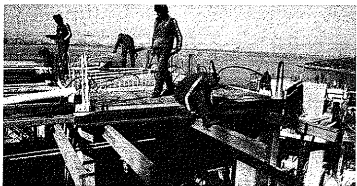
Gradbišče Stinice — opaž plošče z opažnim sistemom Pionir — 2000
