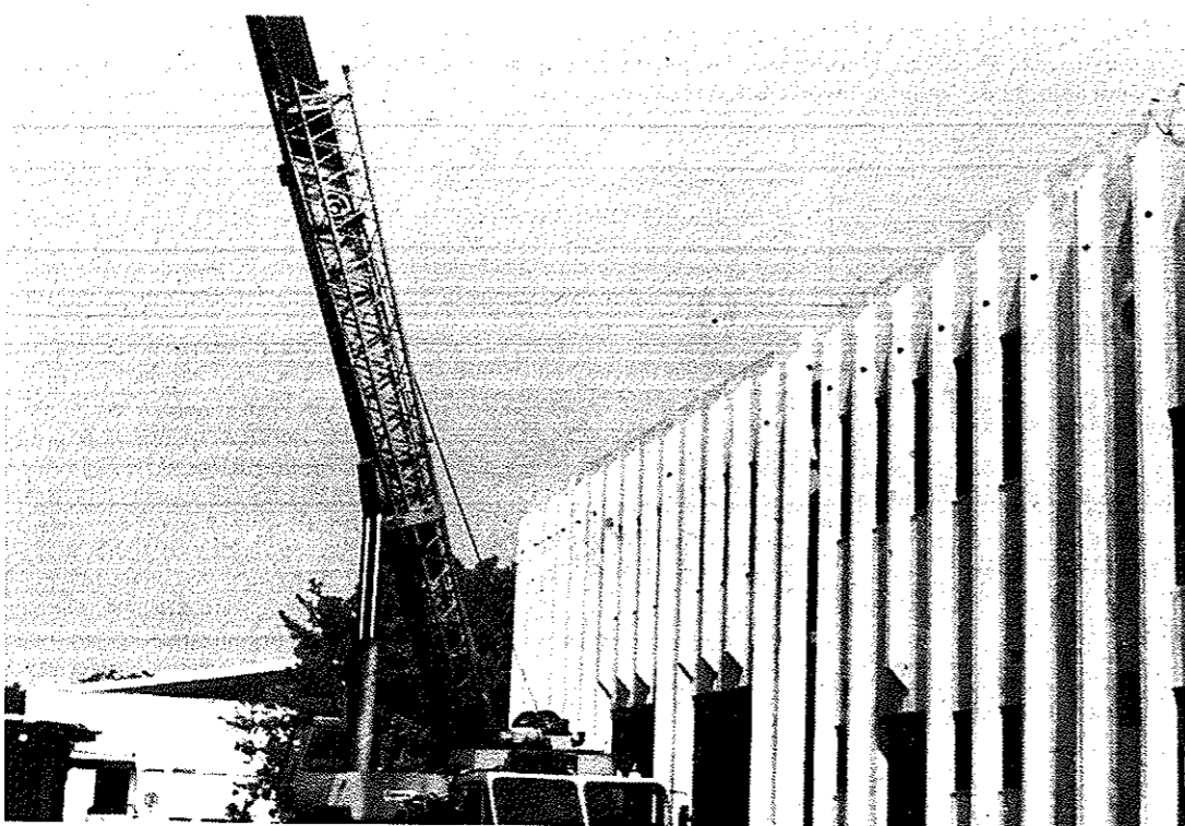
Gradbišče SRO Borongaj Zagreb
