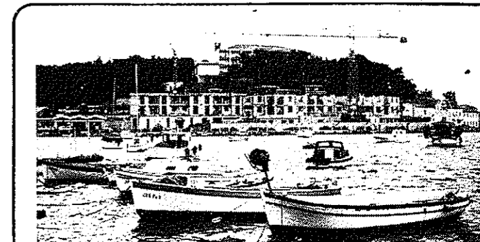
Apart hotel Marina v Vrsarju — Pričetek gradnje je bil peti februar 1986, zaključek del pa 15. maja 1986. Vodja gradbišča s 110 delavci, Jože Murn, je povedal, da je površina objekta 3200 m 2 . Investitor je DO Anita iz Vrsarja. V objektu bo 32 apartmajev, slašičarna, pivnica, samopostrežna restavracija in terasa. (Foto: Borsan)
