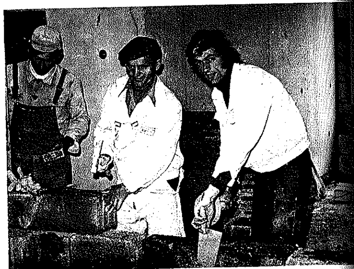
Med tem ko drugi še postavljajo dve nadstropji više tunnelske opreme, Outinord za gradnjo gornjih etaž, v spodnjih že zidarji zidajo vmesne stene iz betonskih zidakov ali iz siporexa
