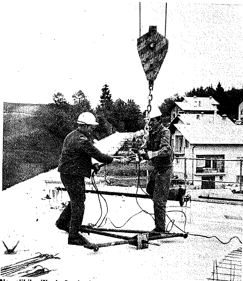
Na velikih višinah, še zlasti na plošči vrhnje etaže, pride zelo prav žerjav, ki prinese s tal vse potrebno
