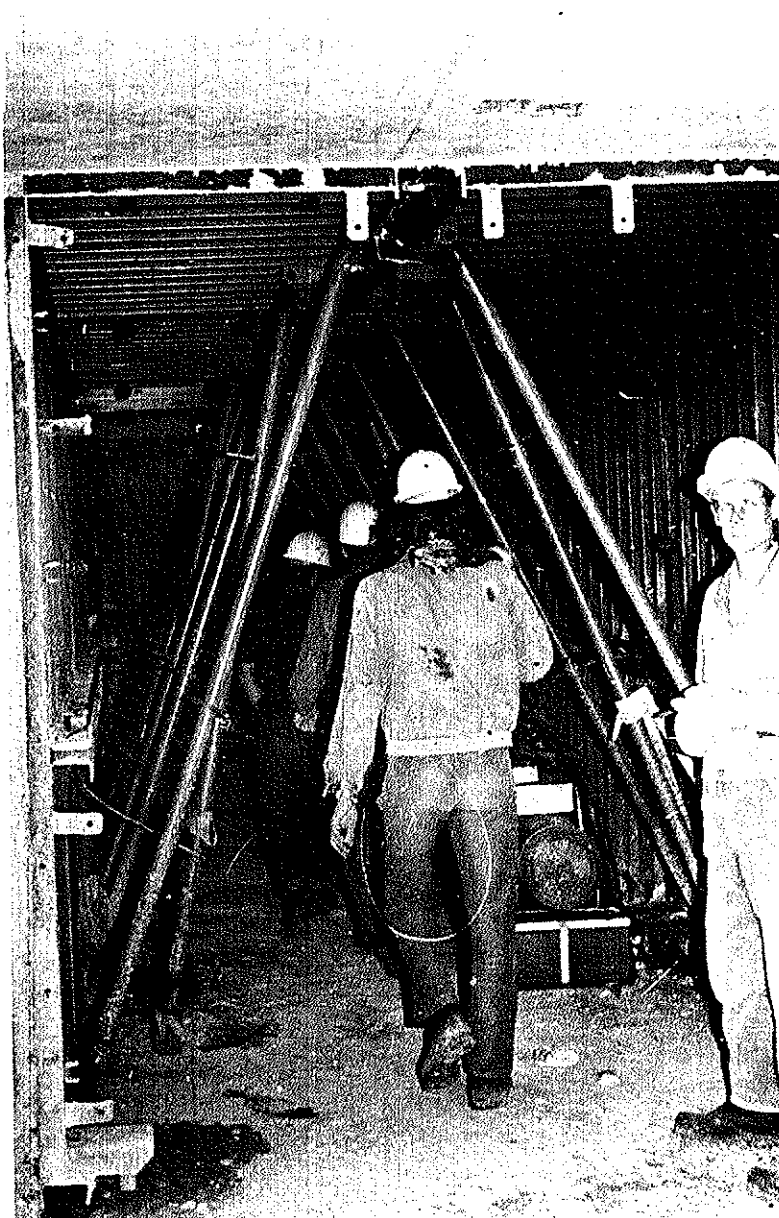
Notranjost jeklenega OUTINORD opaža je res podobna tunelu, zato tudi rečemo temu opažu tunnelski opaž
