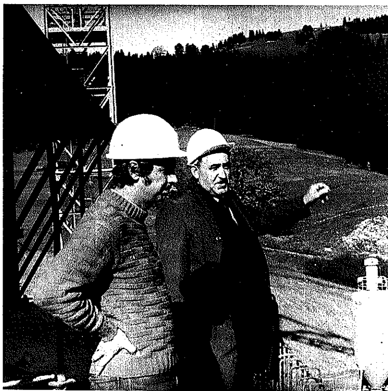
Glavni direktor Ivan Kočevar se je na svojem obisku gradbišča v Zakopanem zelo podrobno seznanil s tamkajšnjo problematiko in si temeljito ogledal gradnjo. Na sliki: med ogledom gradnje objekta
