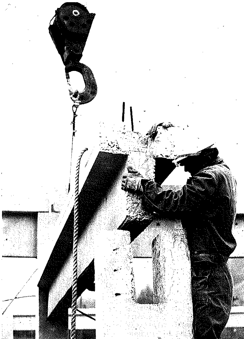
Delavec namešča TOGREL betonski montažni element v ležišče
