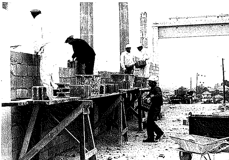
Ločni elementi in nosilci še niso niti postavljeni, zidarji pa že hite v Bos. Petrovcu zazidavati vrzeli med nosilnimi stebri z zidaki
