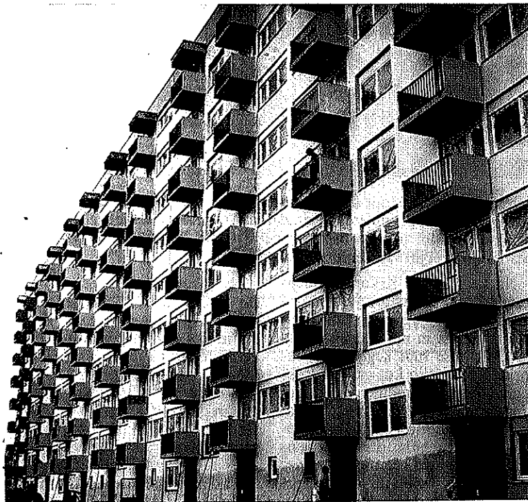
Pogled na del 130-stanovanjskega bloka UTRINA v Zagrebu, ki ga je zgradil sektor Krško
