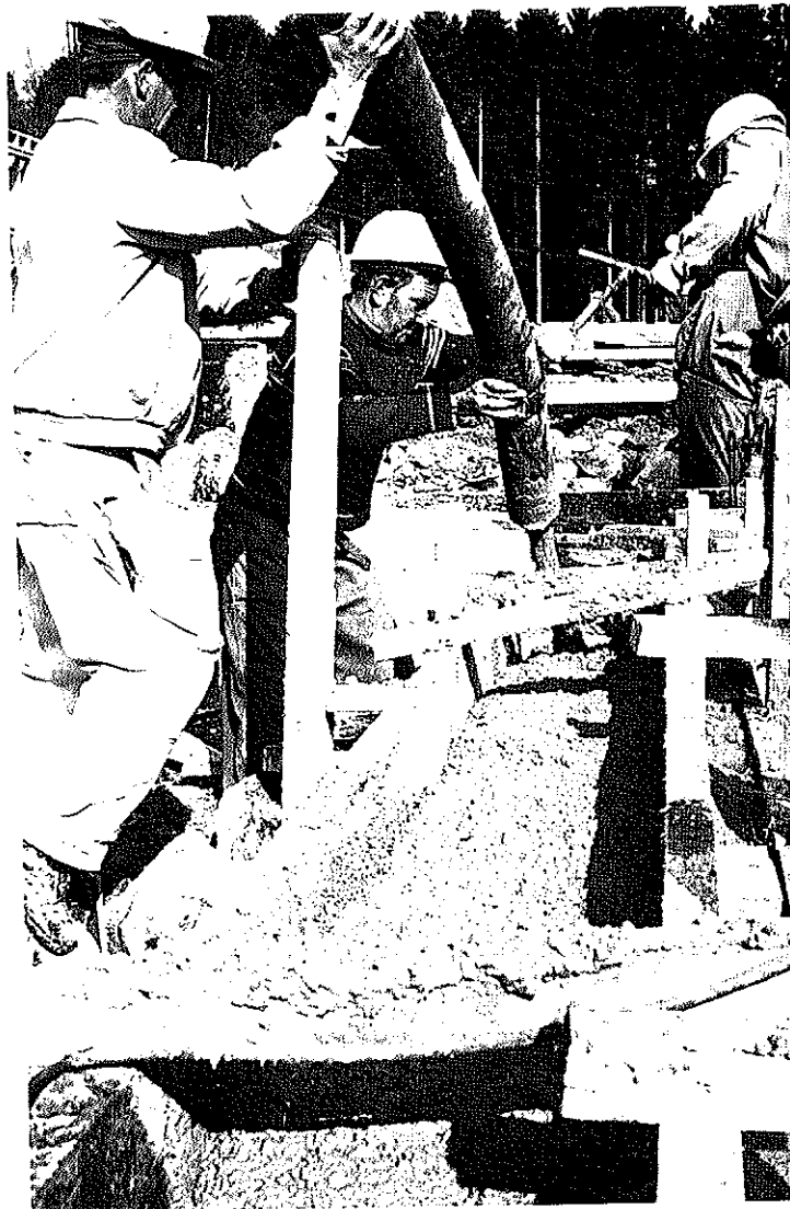
Cev betonske avtočrpalke so namestili nad opaž in zdaj avtočrpalke sedno bruha beton vanj
